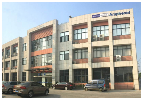
常州工厂外景 Changzhou factory
